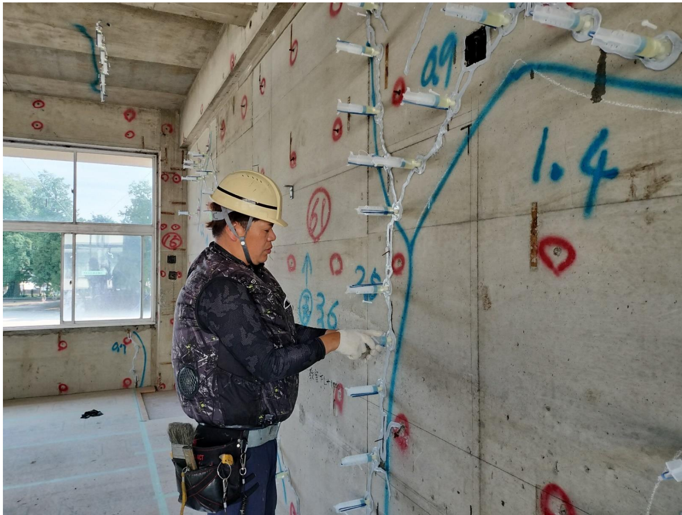
作品名：古い建物を補修して綺麗に 撮影者：土田 葵 コメント：古い建物（校舎）を改修する工事です躯体劣化部分の補修工事を行っている写真です 撮影場所：健軍小学校
