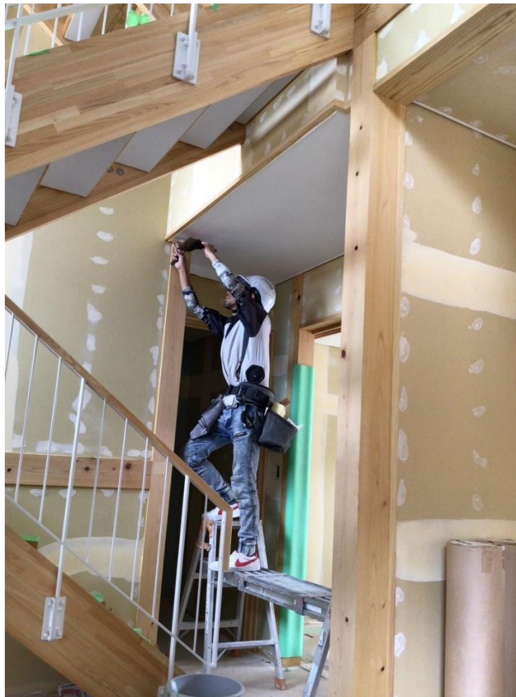
作品名：壁紙の魔法使い 撮影者：谷川 朝日 コメント：壁紙を綺麗に貼っていて、魔法みたいですごいなと思いました 撮影場所：芦北町営住宅新築工事現場
